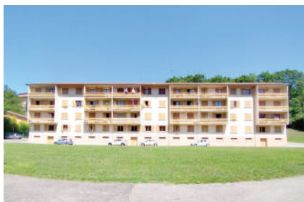
Résidence collective, route de Saint-Fortunat.
