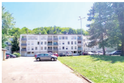
Résidence collective, chemin de l'Indiennerie.
