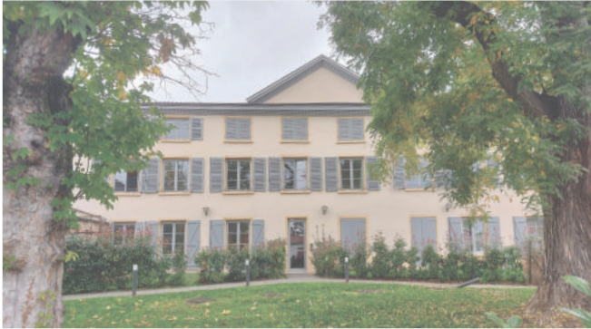
▲ Réhabilitation d'un bâtiment de logements, rue Claude Fouilloux.
