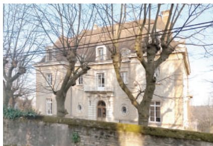
▲ Propriété Riboud, rue de la Chau.
