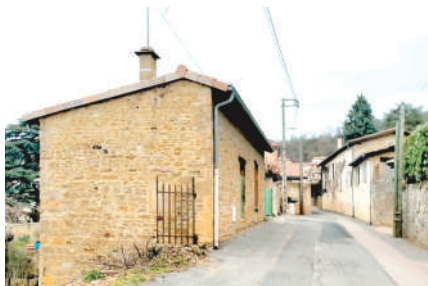
▲ Maison rurale, chemin du Coûter.
