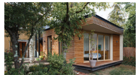
▲ Extension d'une maison, Rillieux-la-Pape (69), Kilinc architecture.
