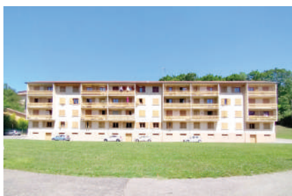
Résidence collective, route de Saint-Fortunat.
