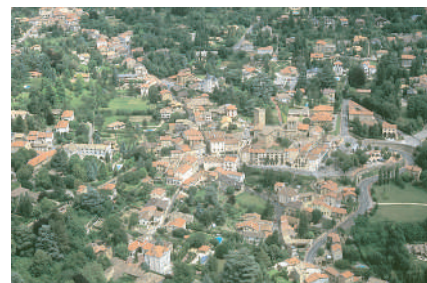
Vue aérienne du centre-bourg.
