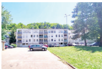
Résidence collective, chemin de l'Indiennerie.
