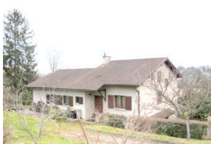
▲ Maison individuelle post-1975, chemin de Garennes.
