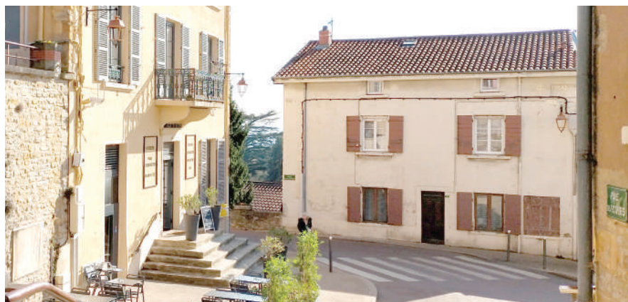
◀ Maison en alignement, place du Général de Gaulle.
