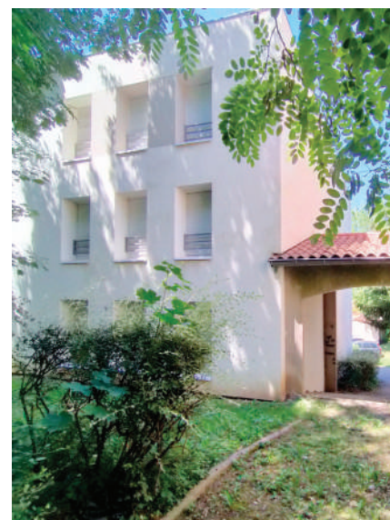
▲ Résidence collective, chemin de l'Indiennerie.
